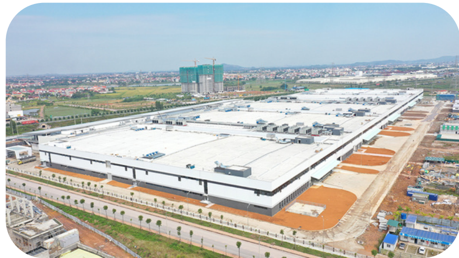
Dự án: Nhà máy Fukang CĐT: CT TNHH Fukang Technology Cung cấp: cáp chống cháy
