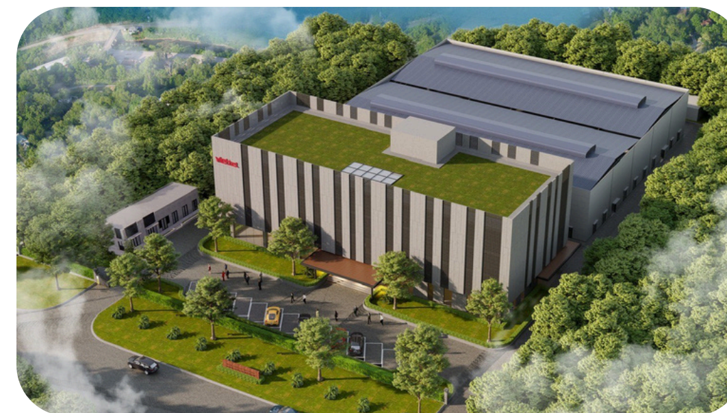
Dự án : M2 Kho Lưu trữ, Hạ Tầng, Phụ Trợ CĐT: Viettel Cung cấp: cáp tín hiệu, ĐK, tủ rack & PK
