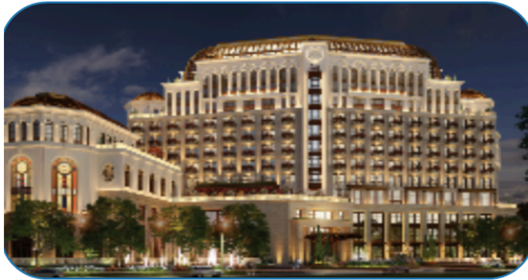
Dự án : Grand Victory Tam Đảo CĐT: Công ty TNHH DLDV Tam Đảo trực thuộc VCI group Cung cấp: cáp tín hiệu, cáp chống cháy và PK
