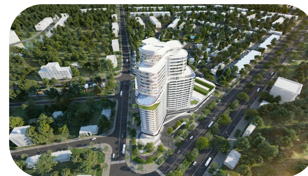
Dự án : The Manor Lào Cai (chung cư cao cấp) CĐT: Bitexco Cung cấp: cáp tín hiệu
