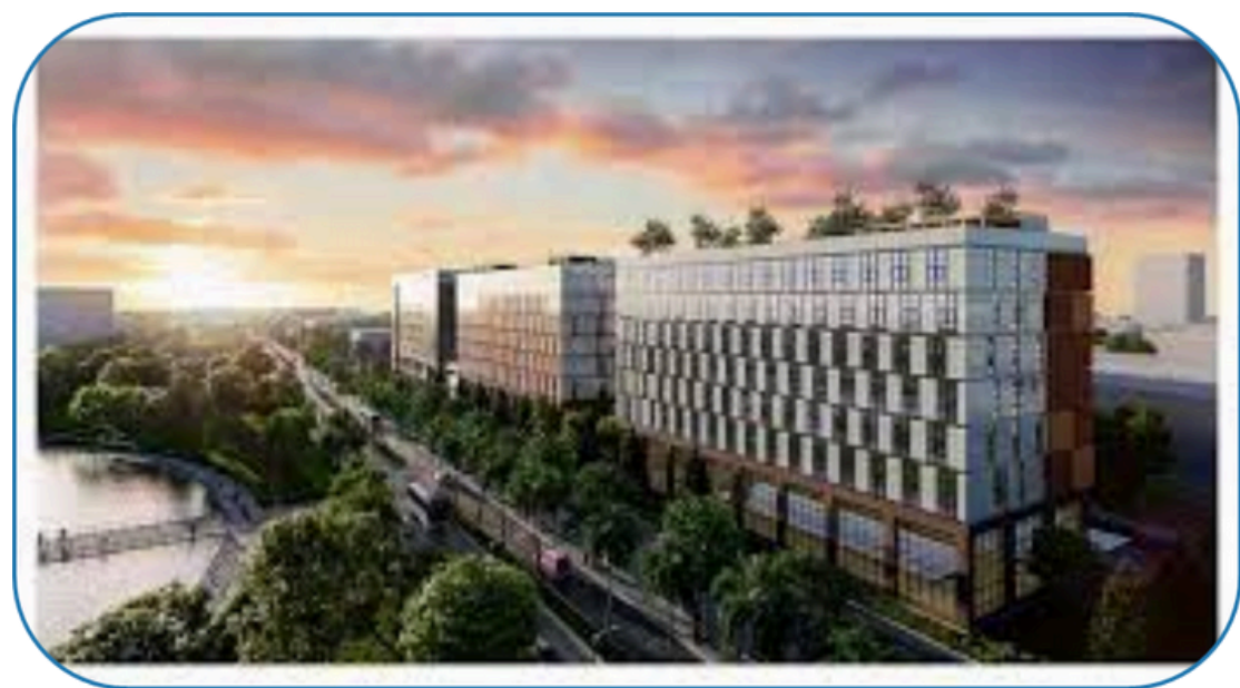
Dự án : Bệnh viện Hạnh Phúc CĐT: CTCP Y Học Vĩnh Thiện ( TĐ Phenikaa) Cung cấp: cáp tín hiệu, điều khiển, chống cháy & PK
