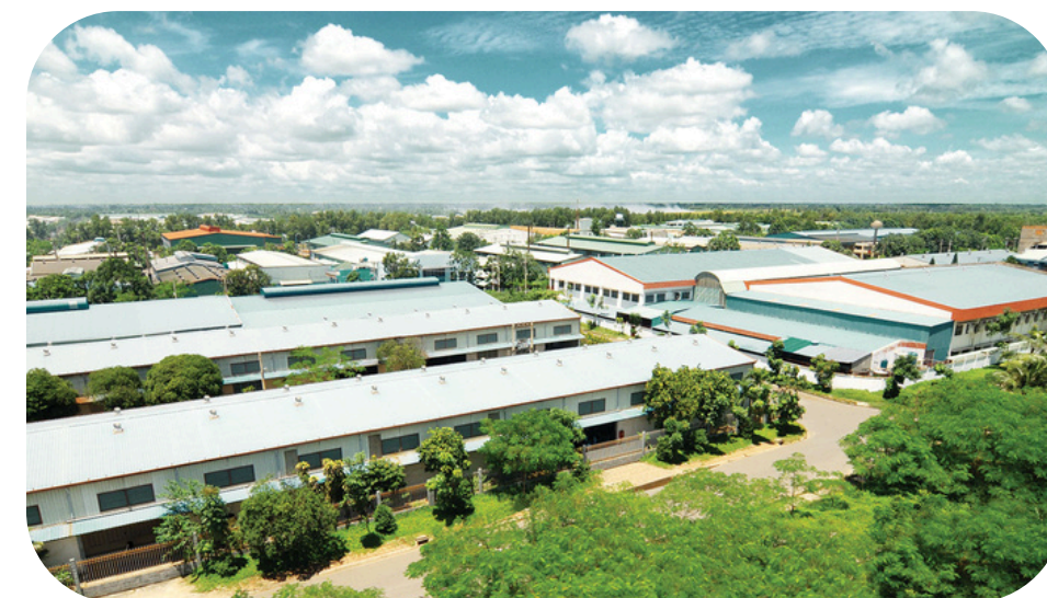
Dự án : KCN Tiên Phong Bắc Ninh CĐT: Công ty Cổ phần TP Bắc Ninh Cung cấp: cáp tín hiệu, PK Tủ rack
