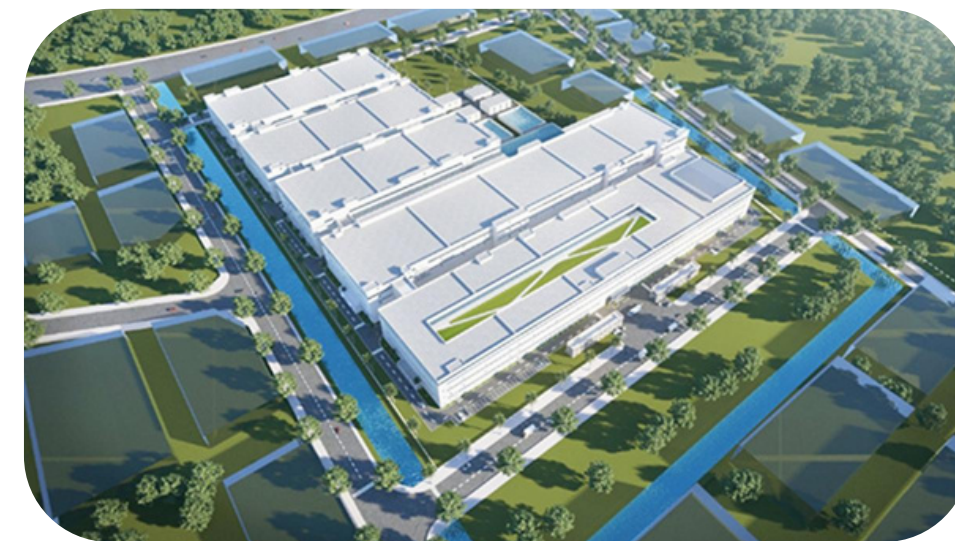
Dự án: Nhà máy Lens Bắc Giang CĐT: CT Công Nghệ LENS Cung cấp: cáp tín hiệu, cáp chống cháy
